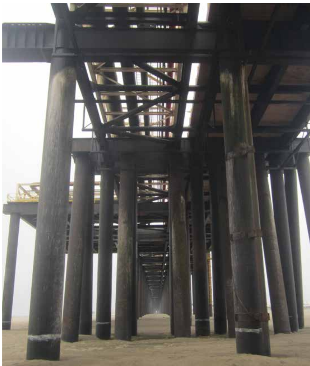
Pampa Melchorita Gas Export Pier and Jetty, Peru LNG
